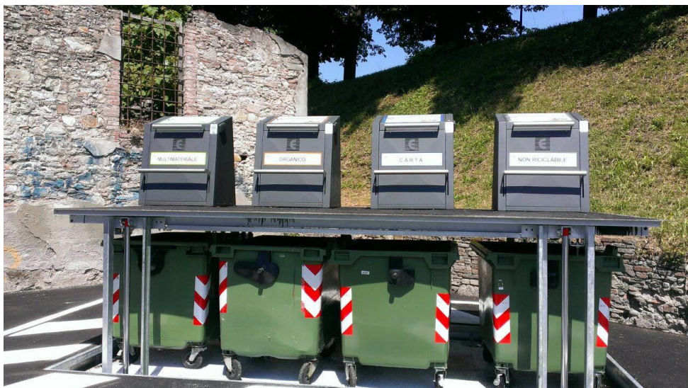
Particolare di un'isola interrata del Centro Storico
